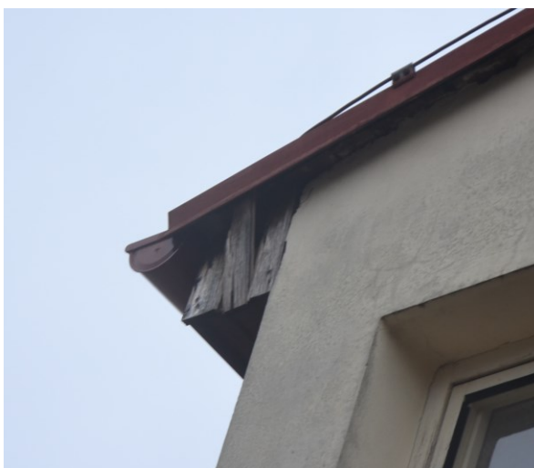
Obr 9 - 10 : Drobná prasklina v omítce a porucha podbití.
