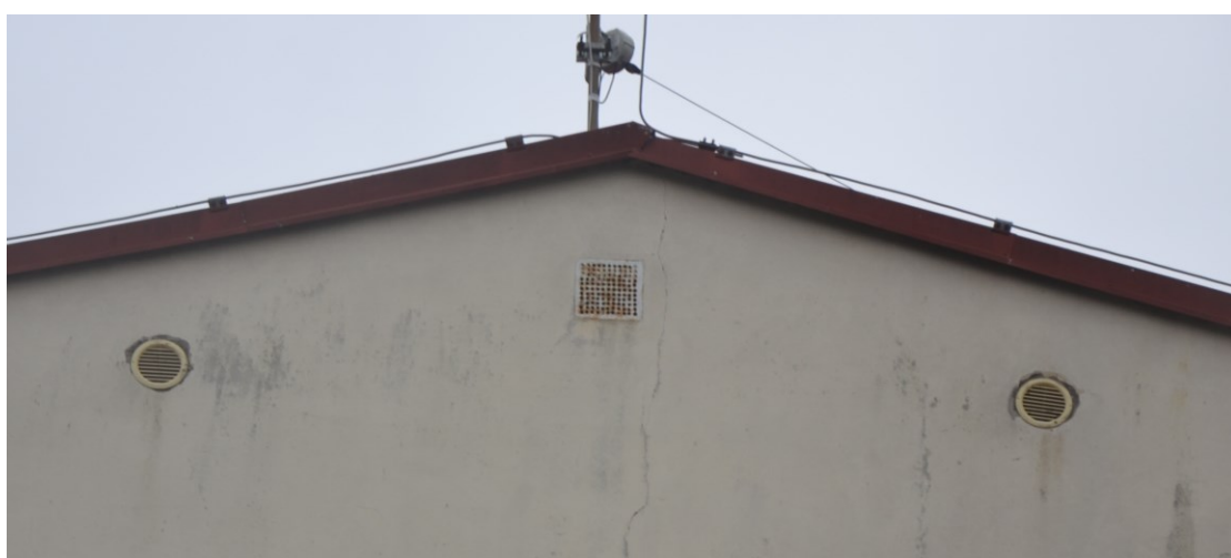
Obr 7 - 8. Všechny větrací otvory jsou neprostupné.
