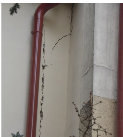
Obr 9 - 10 : Drobná prasklina v omítce a porucha podbití.
